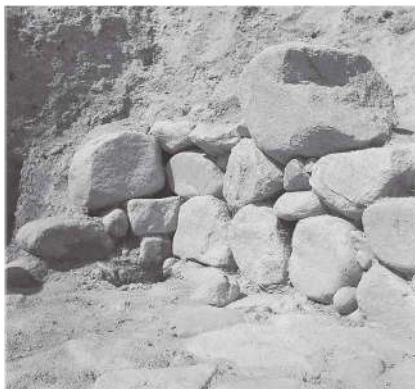
左側壁奥壁側
